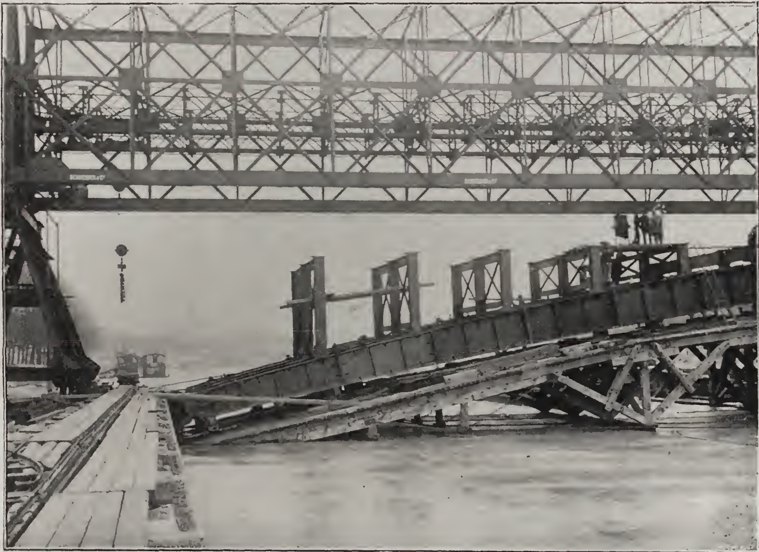
LE PONT ALEXANDRE III. — Montage des supports verticaux (vue d'aval).
